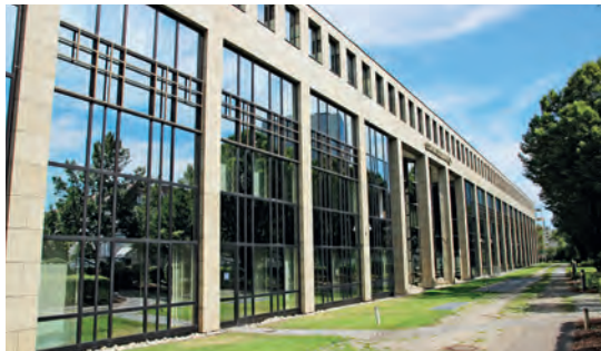
Die Fassade der Commerzbank ist mit braungetöntem, stark spiegelndem Glas ausgestattet (Foto: E. Wölf).
