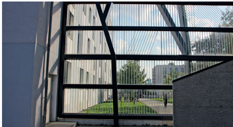
An der strukturierten Schallschutzwand am Frankfurter Ring mit vogelschlagsicherer Markierung wurde keine einzige Kollision festgestellt (Foto: E. Wölfel).
